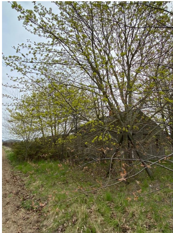
Blick von Westen ehemalige Produktionsstätte, verbuschend
