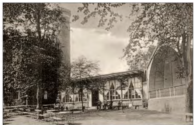
Der Bau des Belvedere-Schlösschens mit Anlagenlokal wurde 1873 begonnen und 1878 in Regie des Verschönerungsvereins vollendet. Bereits vorher bestand eine Konzertbühne.
