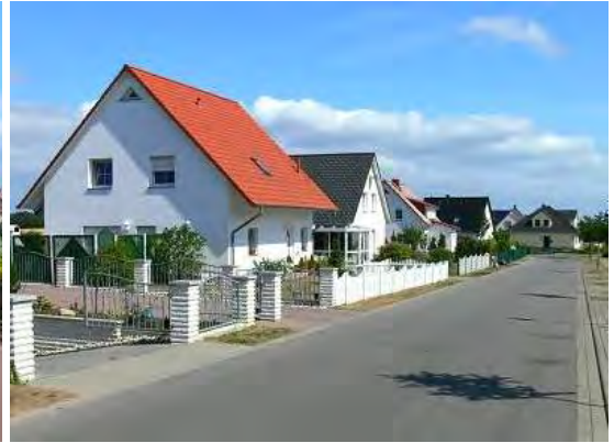
Neue Wohnhäuser, Baujahr nach 1990
