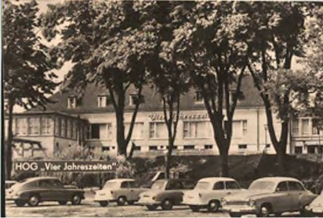
Ehem. Gaststätte „Vier-Jahreszeiten“
