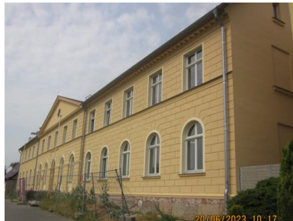
in Sanierung im Jahr 2023
