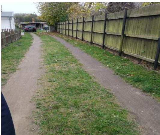
Abbildung 7 unversiegelter, stark verdichteter Weg
