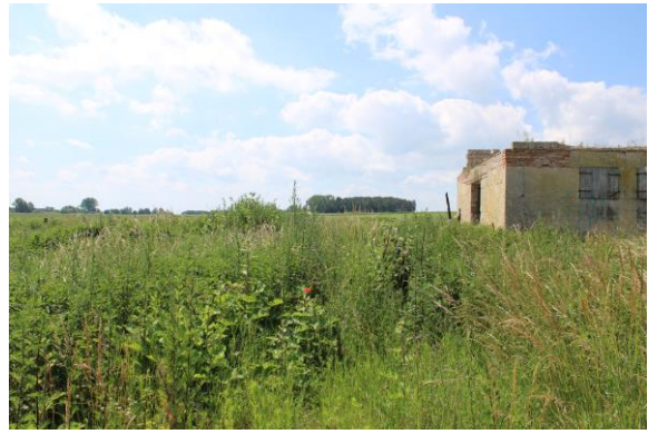
Abbildung 14 Ruine der ehemaligen LPG-Anlage
