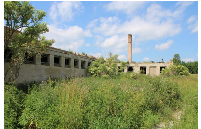
Abbildung 16 Ruine der ehemaligen LPG-Anlage
