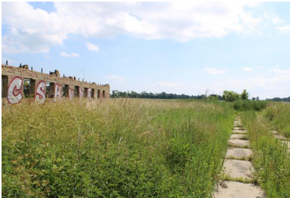
Abbildung 15 Ruine der ehemaligen LPG-Anlage
