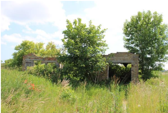
Abbildung 13 Ruine der ehemaligen LPG-Anlage
