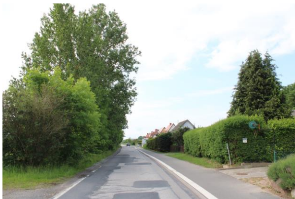
Abbildung 9 Kreisstraße VG 29 Blick von Nord nach Süd
