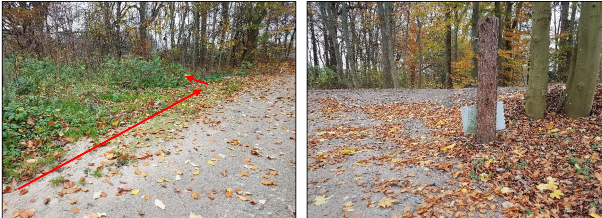
Abb.6-2: Ansatzweise erkennbare Spurrillen (links) Richtung Ablauf vom Pulower See sowie höher gelegene Straße (rechts, hinter der Straße befindet sich der Pulower See in ca. 50 m Entfernung) (Fotos aufgenommen am 16.11.2022)
