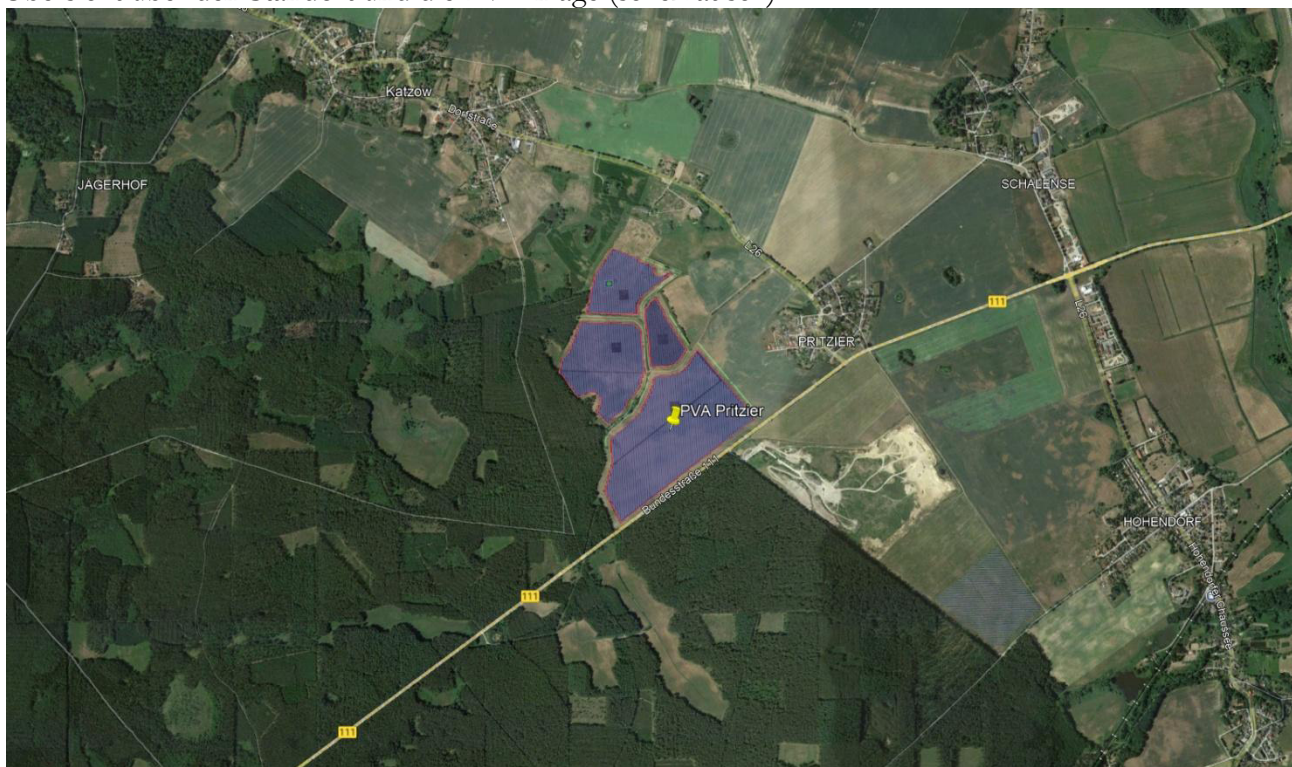
Bild 2.1: Luftbild der PV-Anlage (Quelle: Google Earth / SolPEG)
