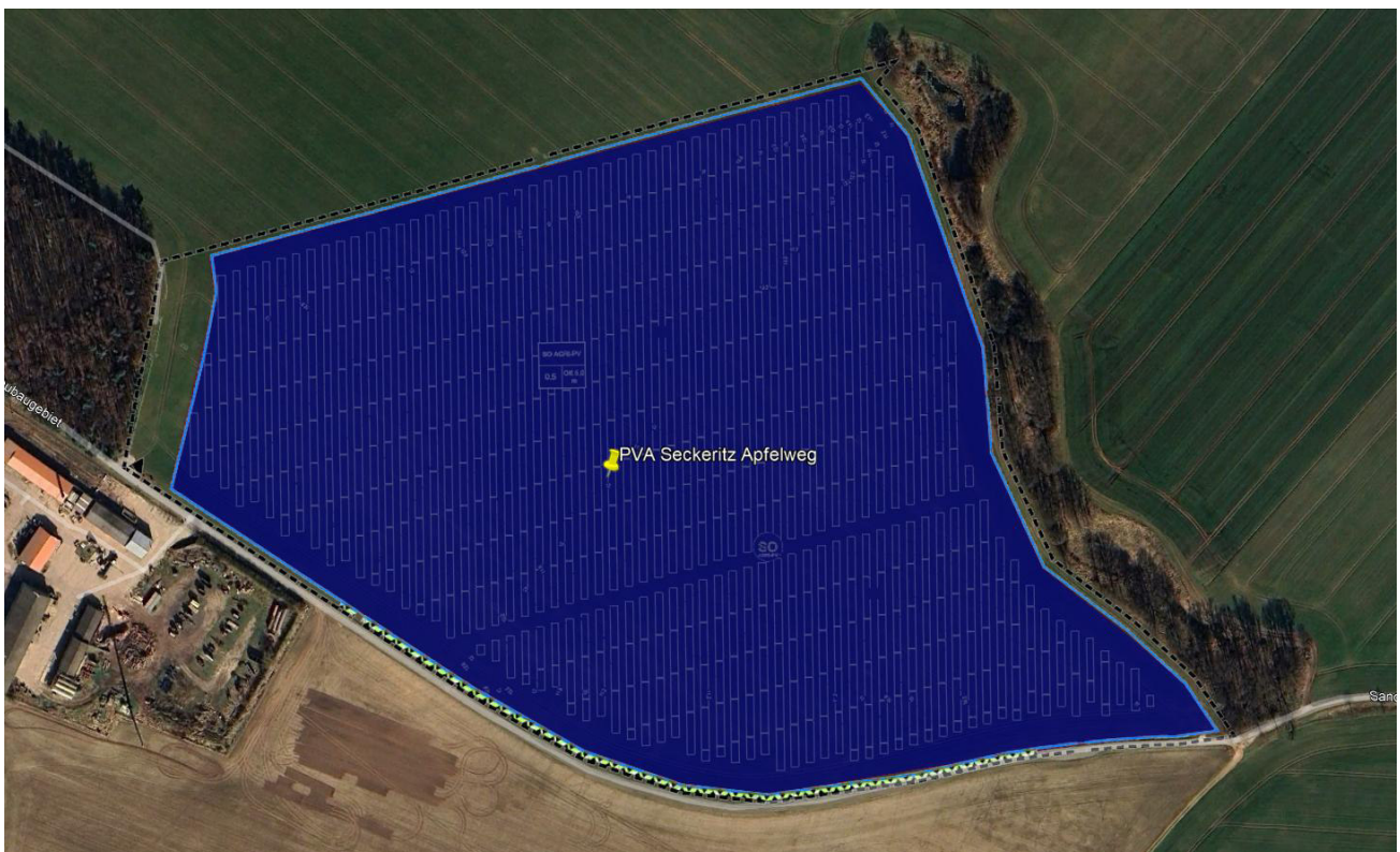
Bild 2.3: Luftbild der PV-Anlage (Quelle: Google Earth / SolPEG)
