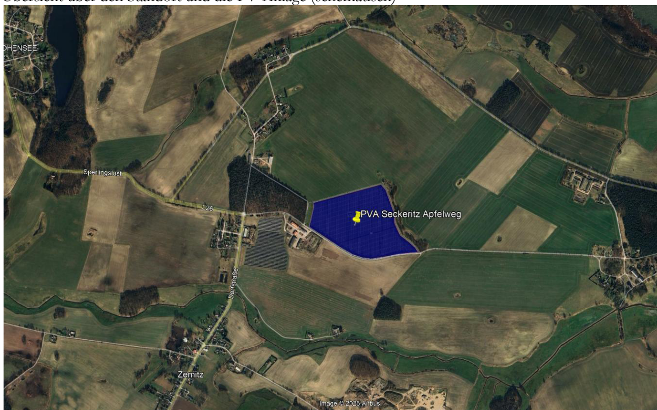
Bild 2.1: Luftbild der PV-Anlage (Quelle: Google Earth / SolPEG)
