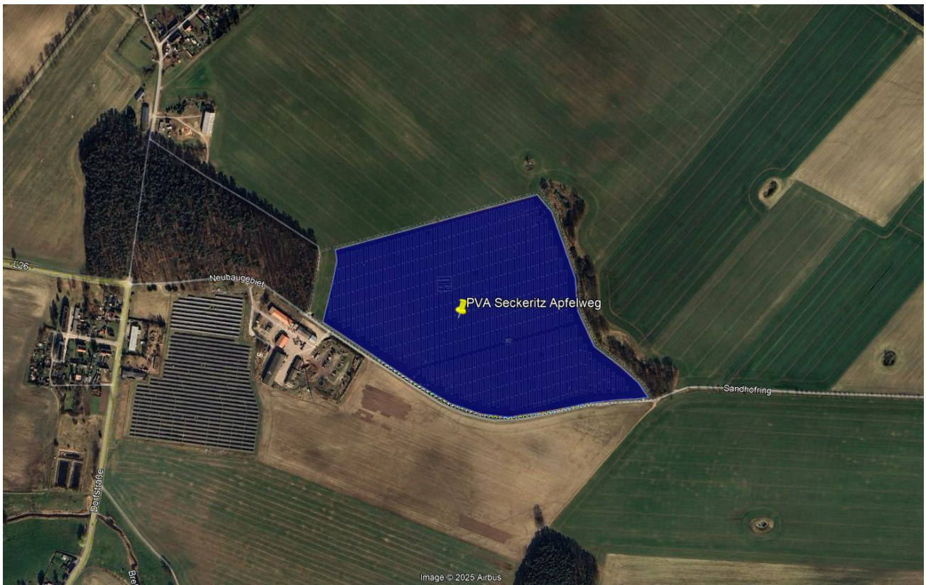
Bild 2.2: Luftbild der PV-Anlage (Quelle: Google Earth / SolPEG)
