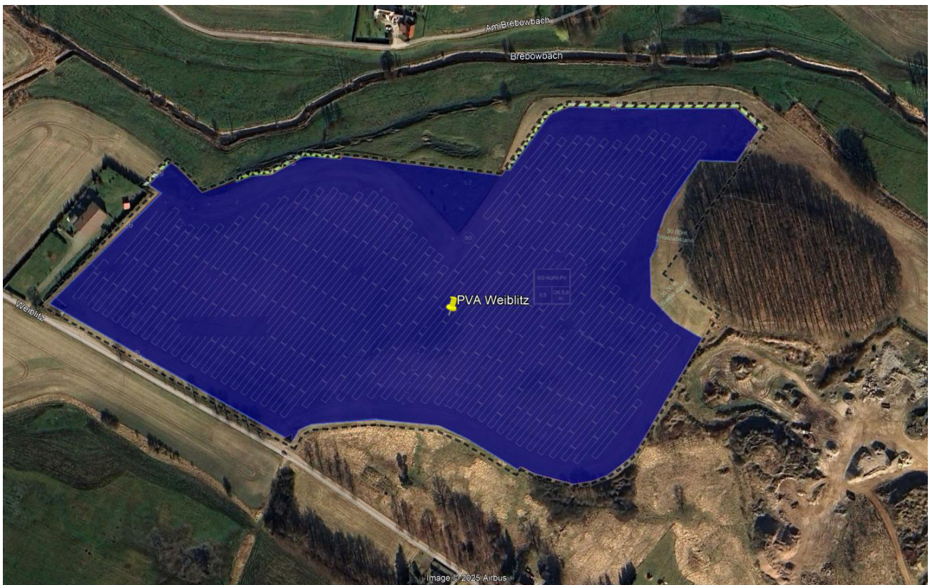
Bild 2.3: Luftbild der PV-Anlage (Quelle: Google Earth / SolPEG)
