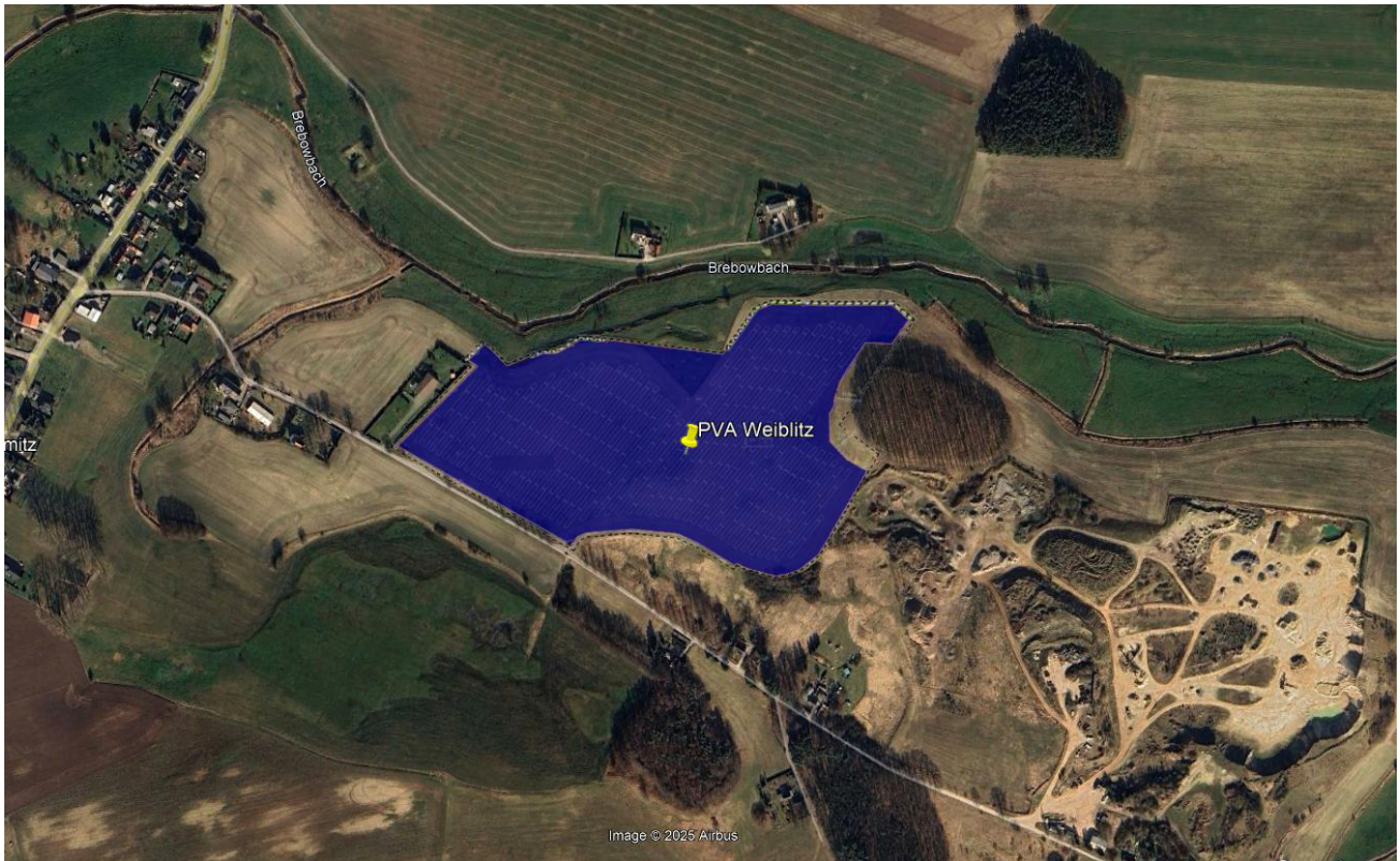
Bild 2.2: Luftbild der PV-Anlage (Quelle: Google Earth / SolPEG)
