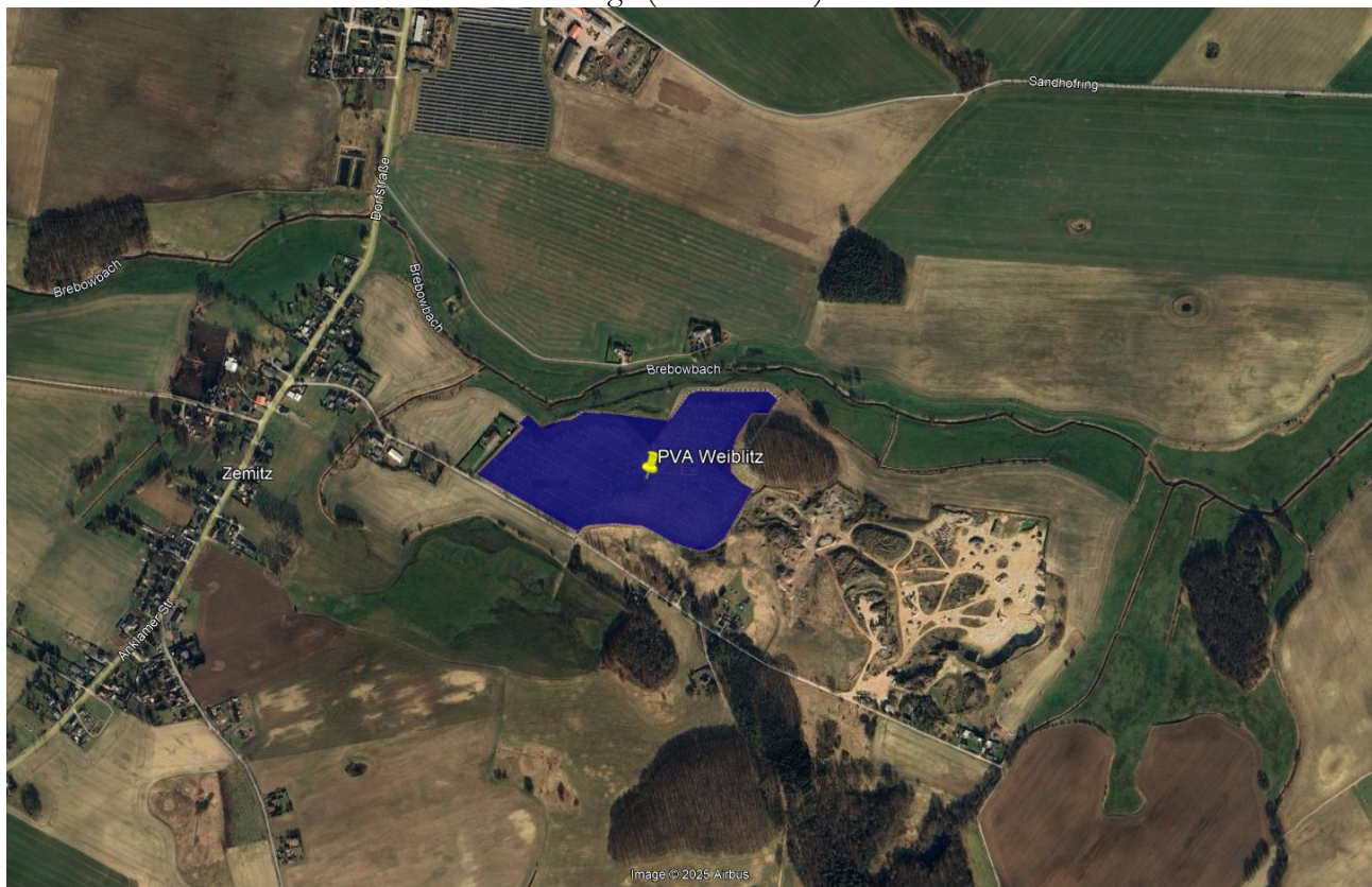
Bild 2.1: Luftbild der PV-Anlage (Quelle: Google Earth / SolPEG)
