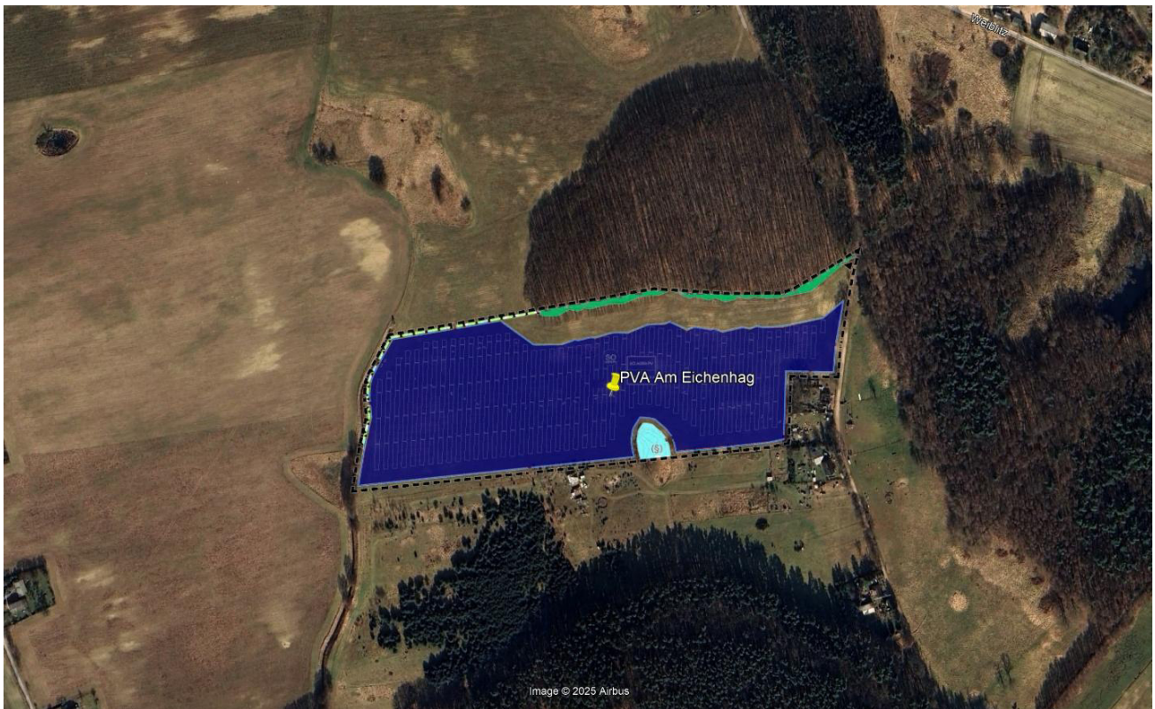
Bild 2.2: Luftbild der PV-Anlage (Quelle: Google Earth / SolPEG)
