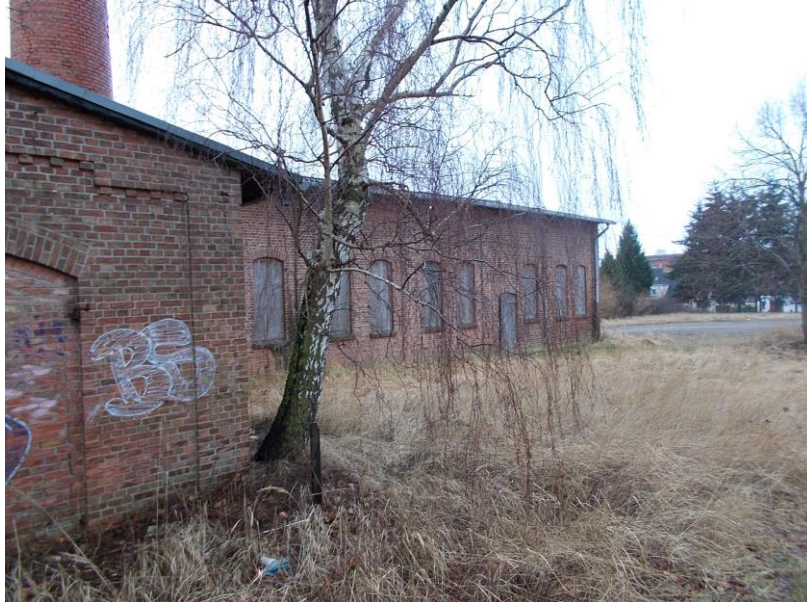
Abbildung 9: Restliche Gebäude auf ehemaliger Industriefläche
