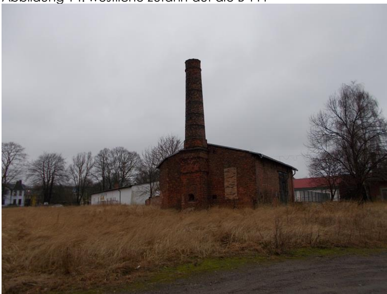
Abbildung 15: verbliebene Industriegebäude auf derzeitiger Brachfläche
