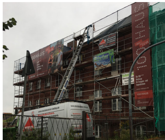
Unterwallstraße 18a – in Sanierung
