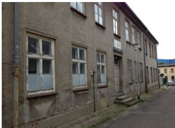
Schützenstraße 8 (ehem. Oberschule)
