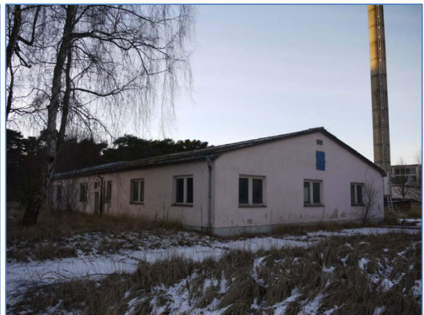
Abb. 12 Betriebsgebäude und Schornstein
