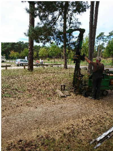
Abbildung 3: Blick auf das Baugrundstück
