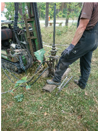
RKB 3 Standort und Bohrung
