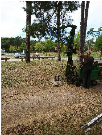
RKB 1 Standort und Bohrung
