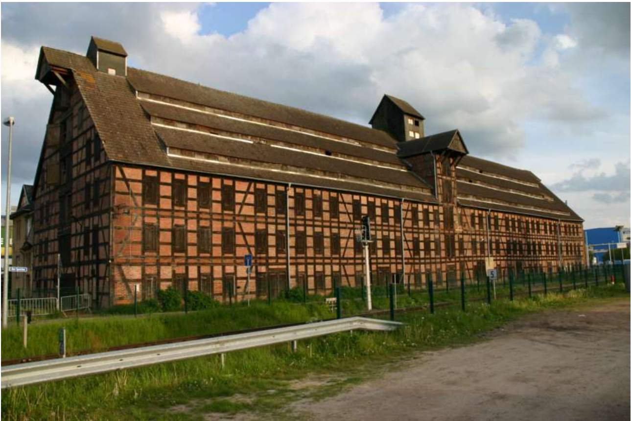
Fachwerkspeicher am Hafen (Kornspeicher), 1836 erbaut, 2006 durch Brandstiftung zerstört
