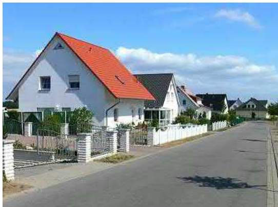
Neue Wohnhäuser, Baujahr nach 1990
