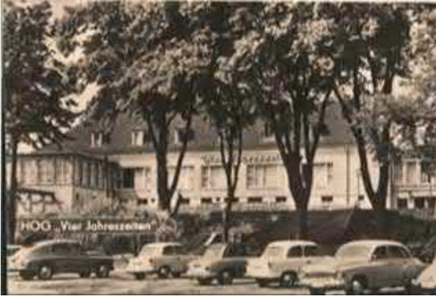
Ehem. Gaststätte „Vier-Jahreszeiten“
