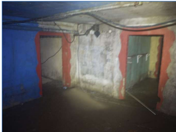
Abb. 13 Der Keller der Gebäuderuine besteht aus vier Räumen.
