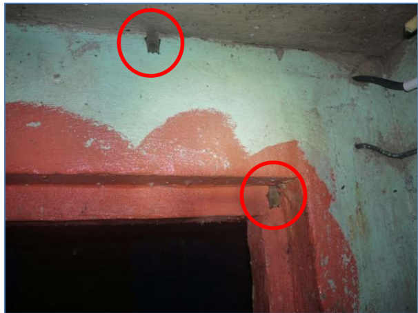
Abb. 11 Überwinternde Wasserfledermäuse im Keller der Gebäuderuine
