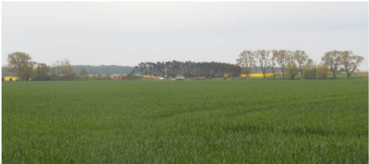
Abbildung 11: Bauschutt-Recycling-Anlage mit östlich verlaufender Baumreihe (links im Bild) und nördlich befindlicher Baumgruppe (rechts im Bild), eigene Aufnahme vom 11.05.2022
